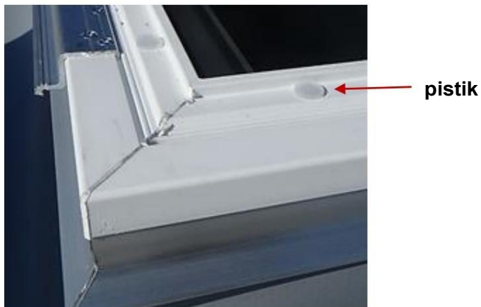
Joonis 12. Korkide paigaldamine PVC alusraami
