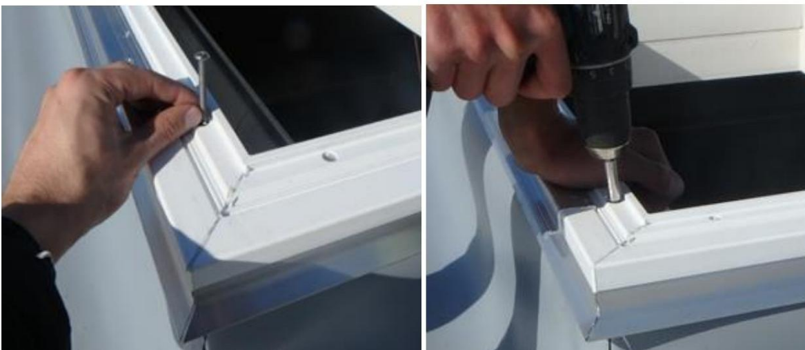
Joonis 11. PVC raami kinnitamine metallaluse külge
