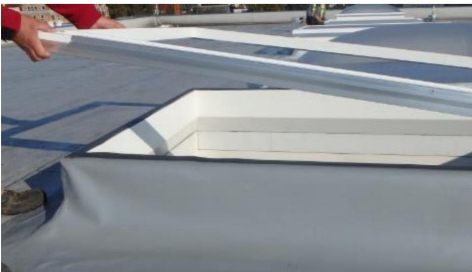
Joonis 10. PVC raami paigaldamine PES-tihendile
