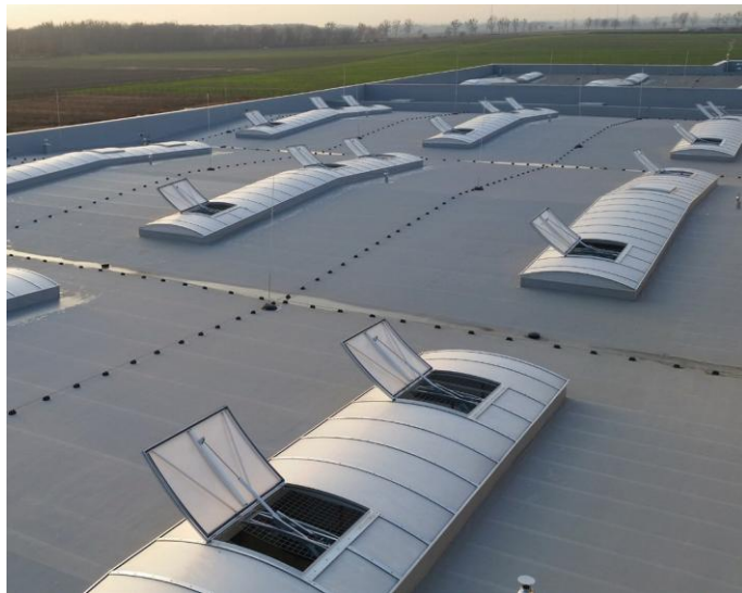
Joonis. 4 – mcr PROLIGHT valgusgalerii laopinna katusel
