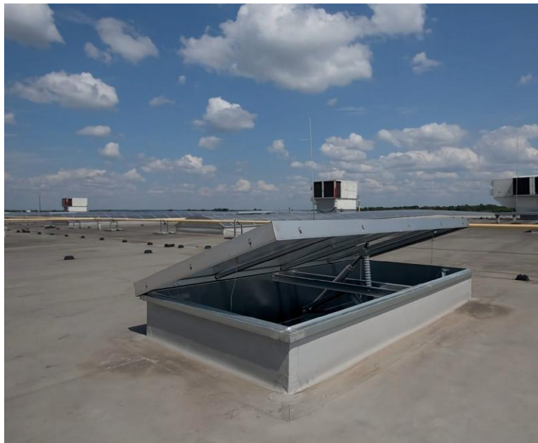
Joonis. 5 – mcr PROLIGHT üheleheline suitsueemaldusluuk, avatud
