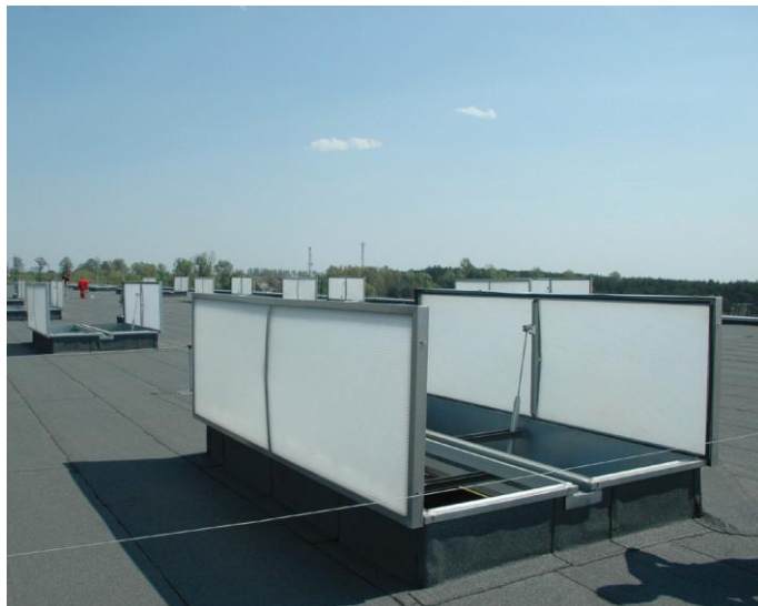
Joonis. 8 – mcr PROLIGHT kahelehelised suitsueemaldusluugid, avatud
