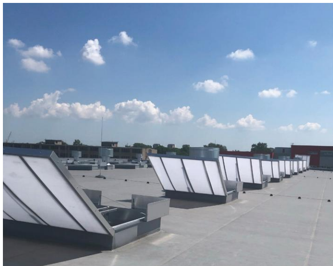
Joonis. 7 – mcr PROLIGHT ühelehelised suitsueemaldusluugid, avatud
