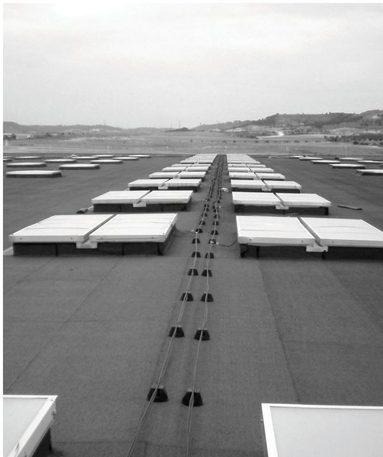
Joonis. 6 – mcr PROLIGHT kahelehelised suitsueemaldusluugid
