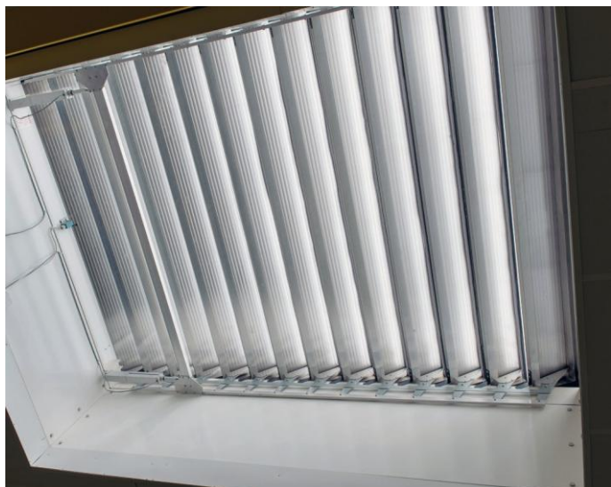
Joonis. 39 – mcr LAM lamellidega ventilatsiooniava, seestvaade
