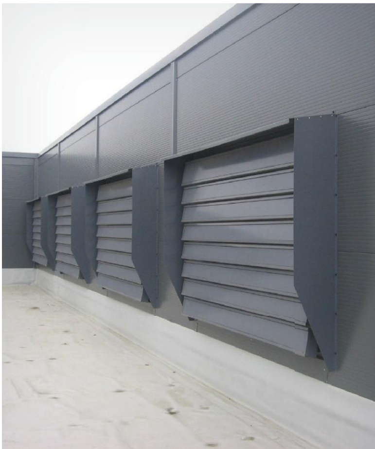
Joonis. 38 – mcr LAM lamellidega ventilatsiooniava, paigaldatud fassaadile
