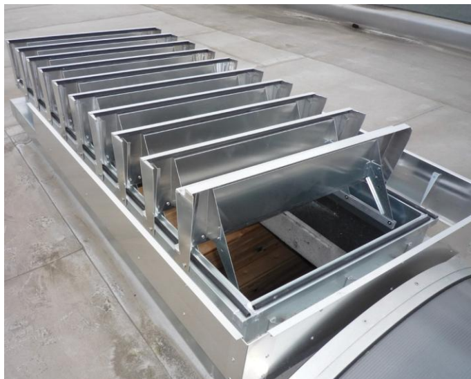
Joonis. 40 – mcr LAM lamellidega ventilatsiooniava, paigaldatud katusele
