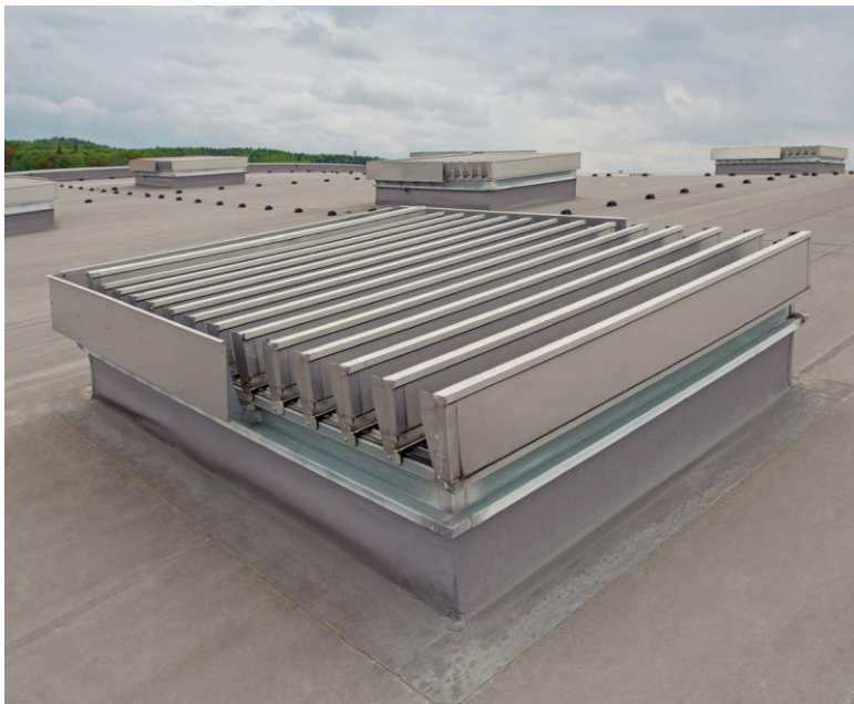
Joonis. 37 – mcr LAM lamellidega ventilatsiooniava, paigaldatud katusele
